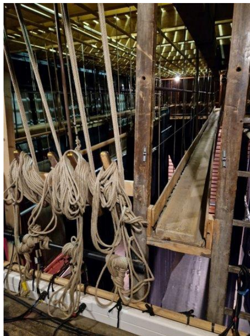
La machinerie et ses cordages
